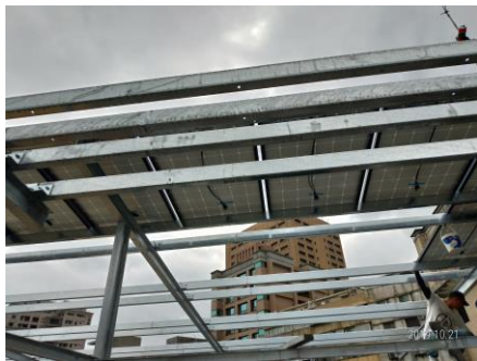
搭建支架，西眺台電大樓！
